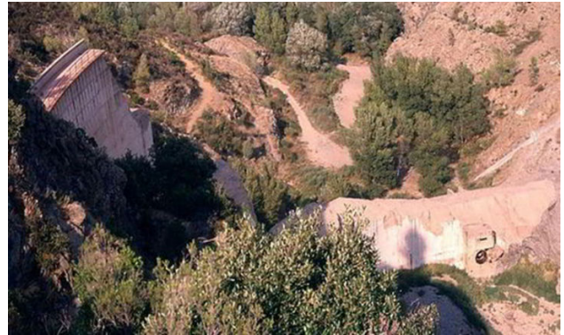
Figura 1. Fallo de la Cortina de la Presa Malpasset, Francia, en 1959 (Farook, 2013)
