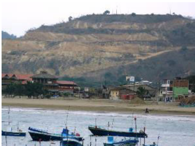
Figura 1. Corrección de taludes en Puerto López, Ecuador (Foto del Autor).
