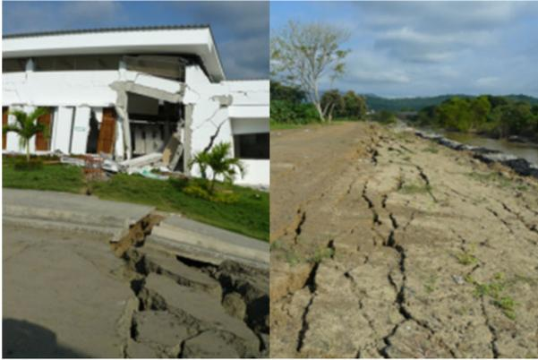
**Fig. 4.** Tercio inferior del río Jama, Manabí, donde se observa, a la izquierda el sistema de diaclasas asociado al fallamiento de orientación NW-SE que elevó ligeramente el terreno y provocó, entre otras, el desplome de la vivienda que aparece a la derecha.
