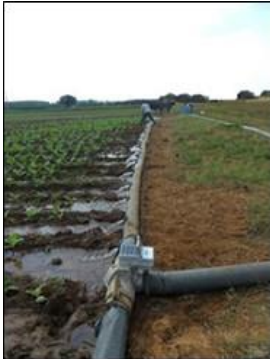
Figura 3. Disposición de las compuertas y válvula de control en el campo de tabaco.
